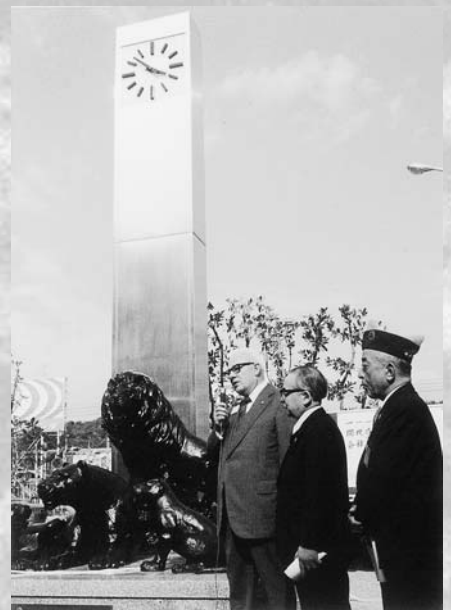
福岡空港に時計塔とライオン像を寄贈した
